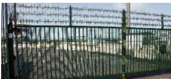
Portail haute sécurité avec rangées de Rota Spike
