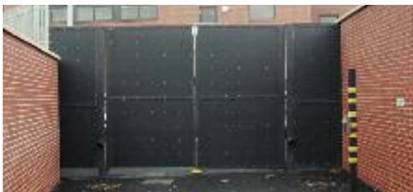
Portail métallique plein
