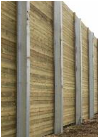
Mur Acoustique Autoroute avec poteaux IPN
